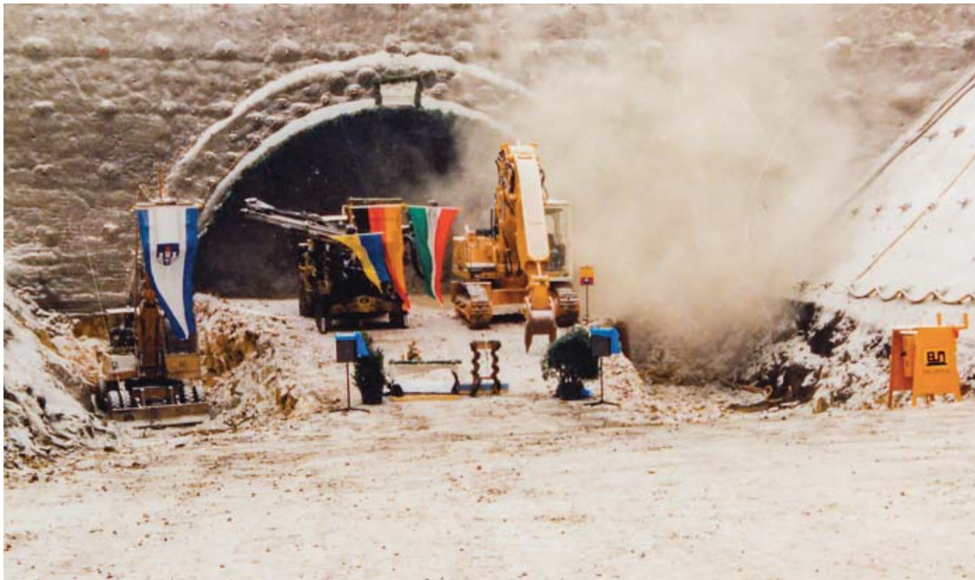
Auftakt der Arbeiten: Am 28. Februar 1998 wurde im Staatsforst Neuenheerse der Tunnel angeschlagen. Das Bild zeigt die erste Sprengung im Fels der Egge.
