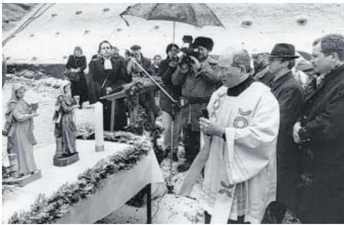
Vor der ersten Sprengung: Ein Gottesdienst wird abgehalten und die Barbara-Figuren werden gesegnet.
